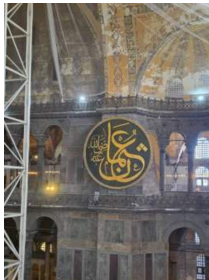
PLANCHE 59 Un médaillon calligraphique parmi les échafaudages des restaurateurs.
